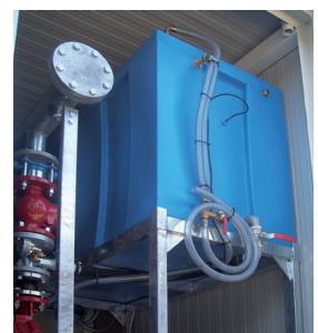
Serbatoio adescamento (in caso di installazione soprabattente) Storage tank in case of abovehead installation
